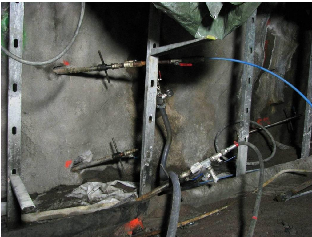
Figur 4-5 Fotot visar injektering i det nedre borrhålet medan vakuumpumpen tömmer det övre borrhålet.
