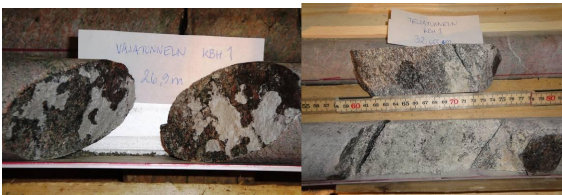
Figur 2-10 Exempel på injekteringsbruk i sprickorna, till vänster cement och till höger talk.
