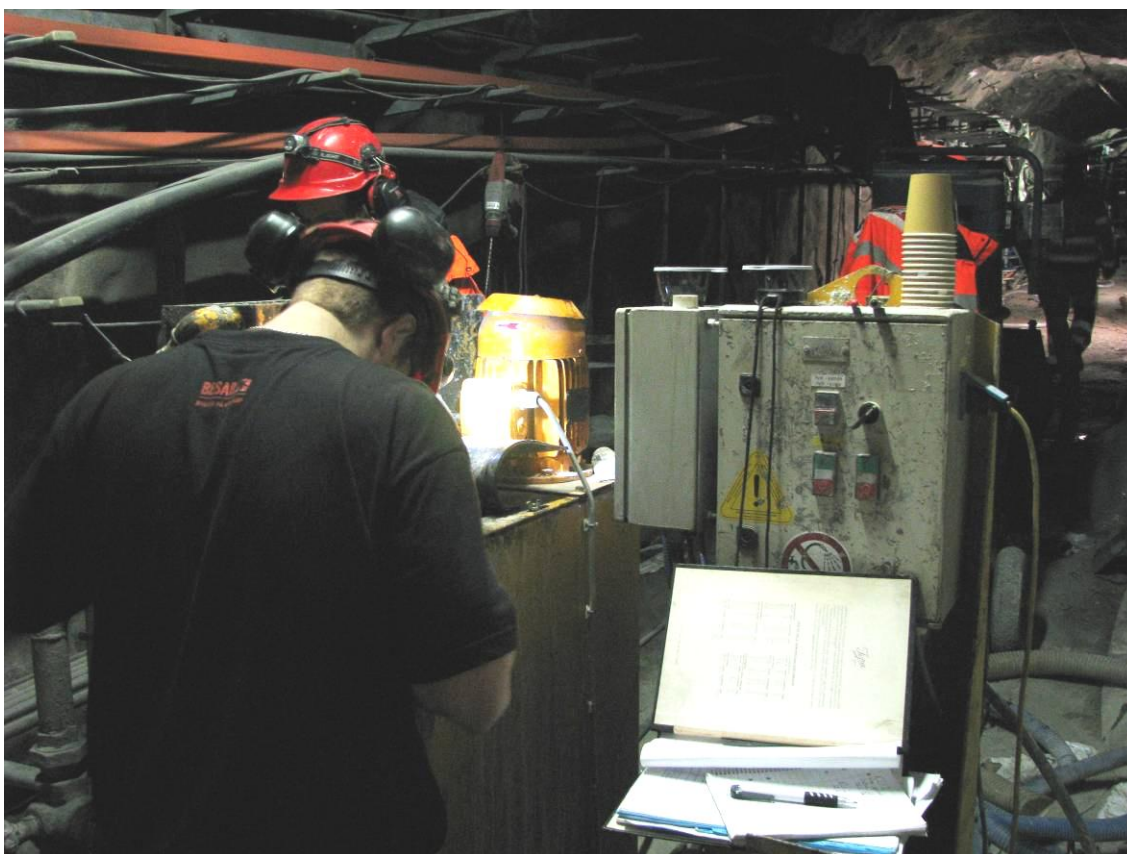
Figur 4-6 Handskrivna protokoll vid sidan av injekteringsloggen.
